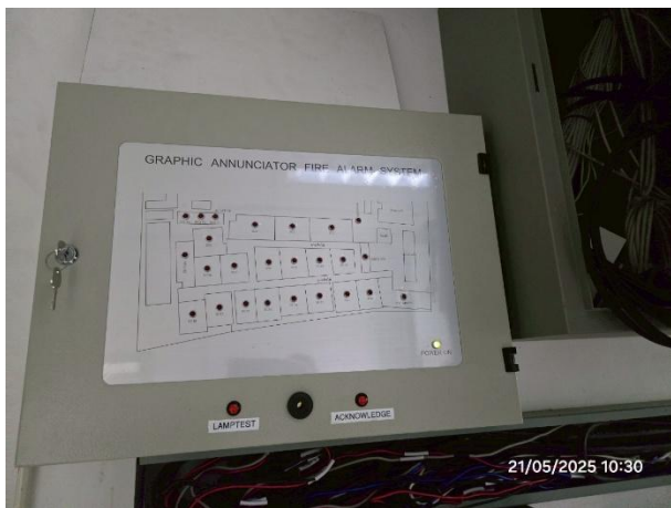
รูปที่ 15 อุปกรณ์สัญญาณแจ้งเตือนอัคคีภัยภายในโครงการ
